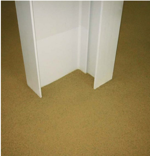
Lavorazione su montante in acciaio
