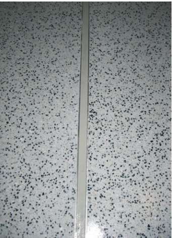
Elaborazione di un giunto di dilatazione
