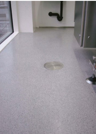
Sigillatura e intervento sullo scarico igienico
