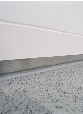
Pavimento alla veneziana montato in pendenza
